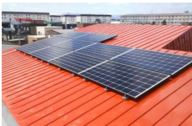
札幌みづほ幼稚園に寄贈された太陽光発電設備
