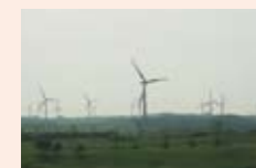
二又風力発電所
